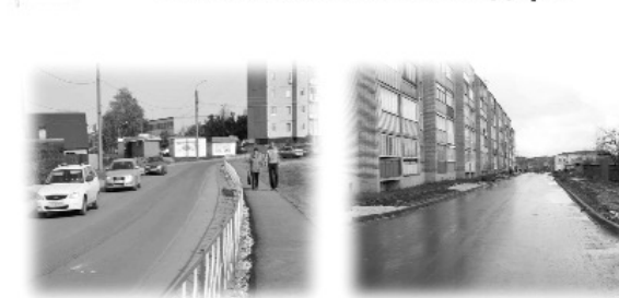
На ремонт автомобильных дорог и дворовых территорий в 2017 году израсходовано 64 млн. руб.
